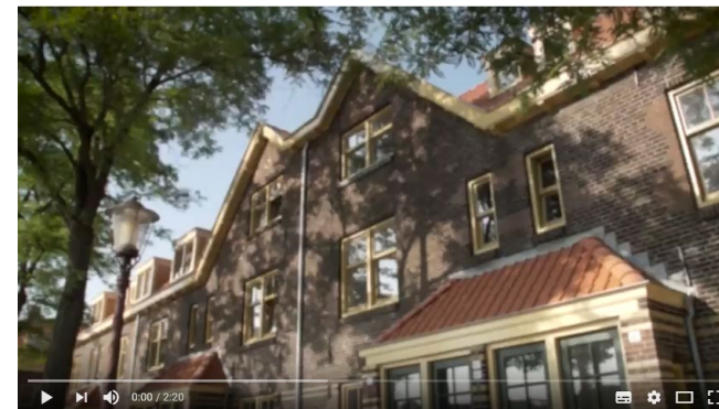
Renovatie, bijv. van der Pek
