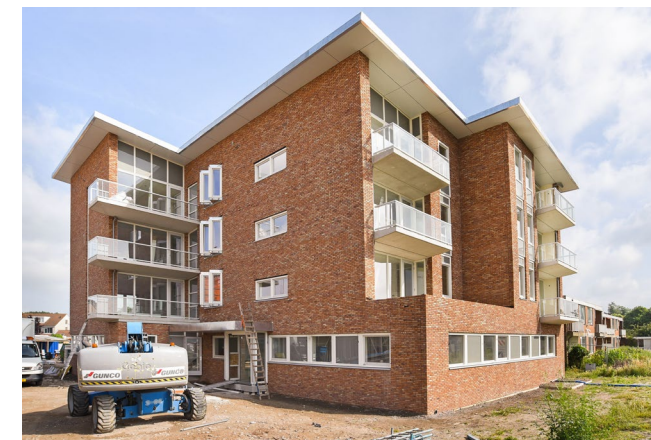
Nieuwbouw, bijv. Mientekade
