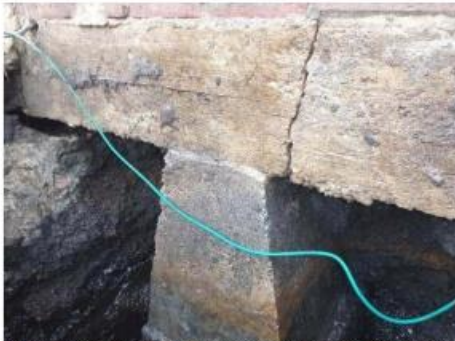
Karel Doormanstraat 40: Scheur funderingsbalk is duidelijk te zien in bovengelegen metselwerk.
