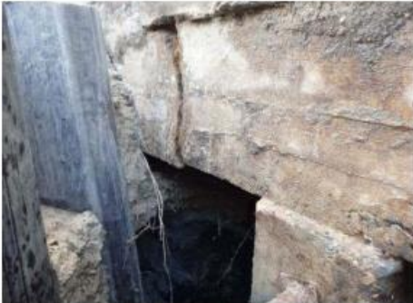
Cor Bruijweg 27: Rondom doorgescheurde funderingsbalk. Deze is reeds 10 mm verzakt.
