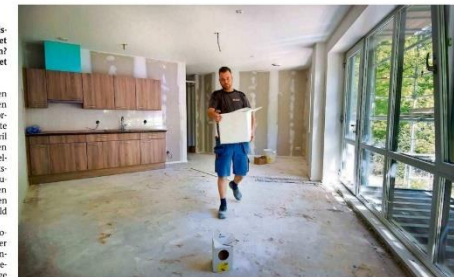
De verbouwing van het voormalige UWV-gebouw tot appartementencomplex is bijna klaar. FOTO: JAN ANNOVA
