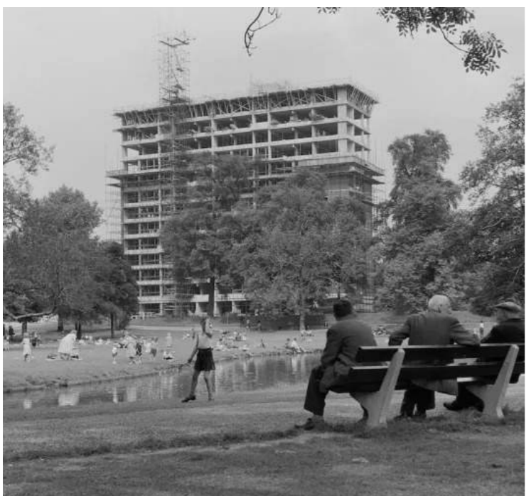
Parkflat in aanbouw gezien vanuit het park. Nationaal Archief, Herbert Behrens / 1957
